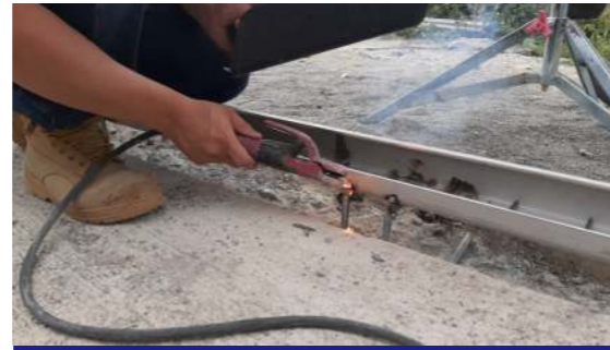
6. 錨定1/2"牙條與地面預埋件焊接
