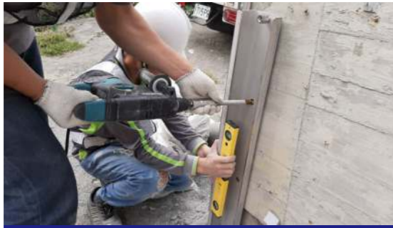
5. 植入M16化學螺栓結合RC與立柱
