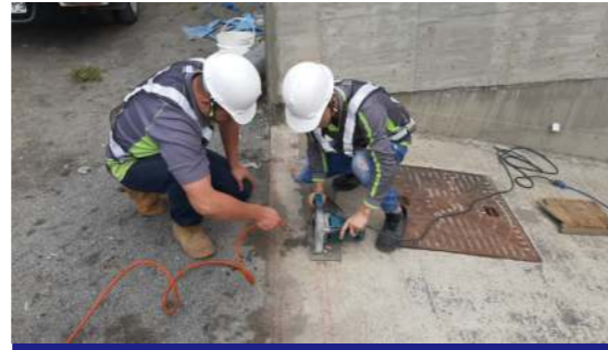
2. 使用水泥切割機切割地面
