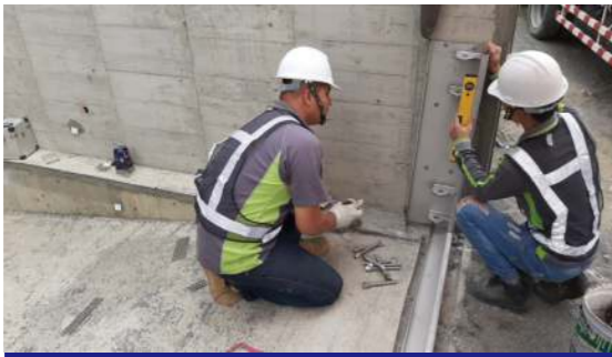
3. 將軌道擺置固定位置後再次確認是否為水平
